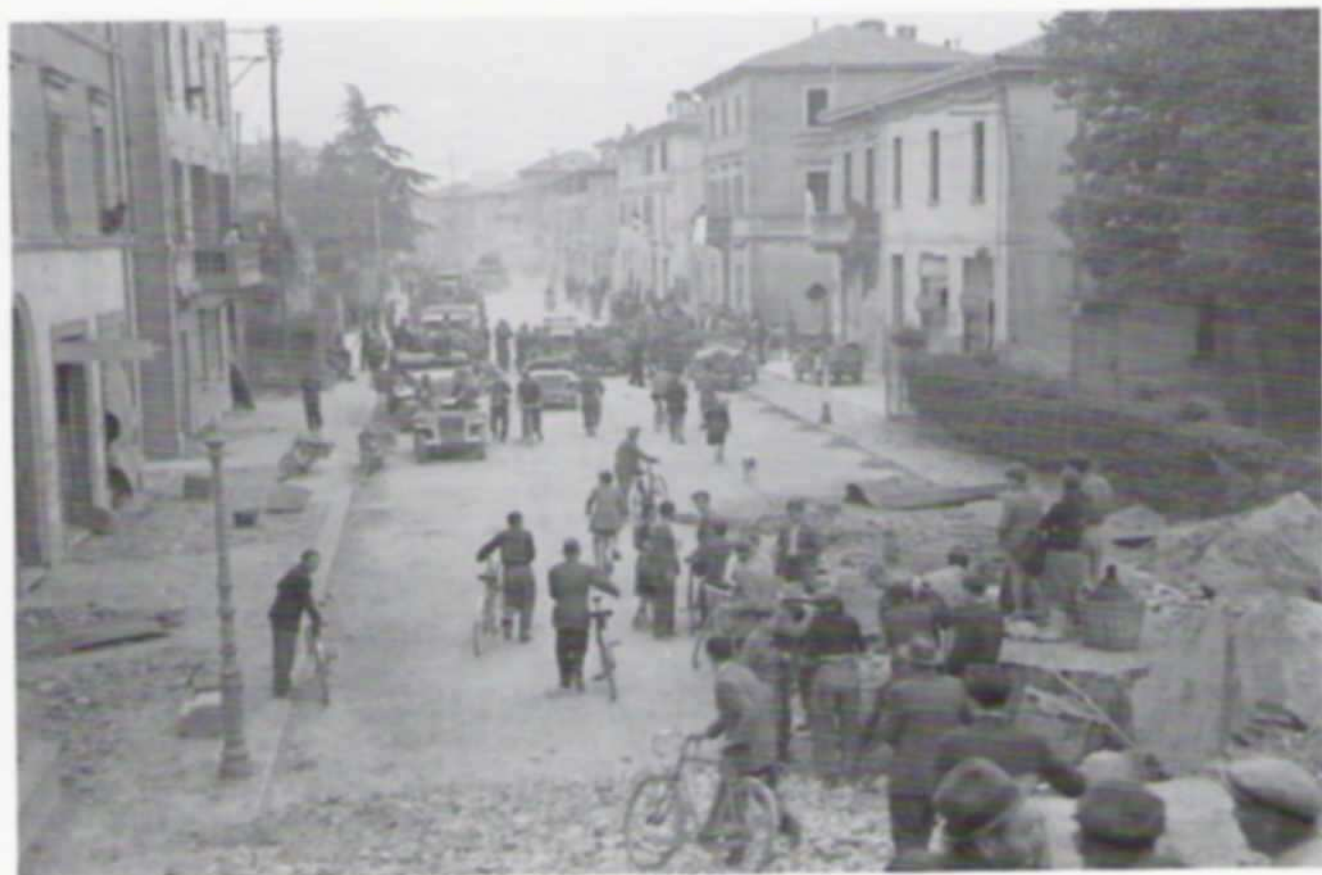
Macerie del ponte ferroviario sulla via Emilia. Resztki zniszczonego mostu kolejowego wzdłuż Via Emilia. (PISM)
